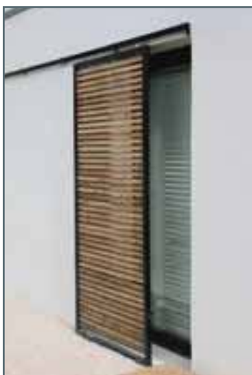
Un type de protection solaire amovible (volet)
