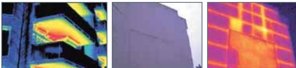
Détection de déperdition thermique à l'aide d'une caméra thermique. (photos Sirtème)
