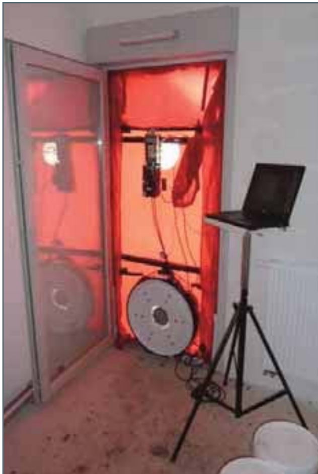
Installation test de la "porte soufflante". (photos Sirtème)
