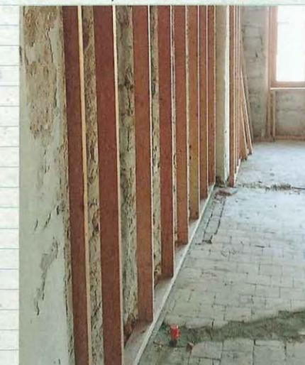
**2** Mettre en place l'ossature bois à environ 25 mm du mur. Elle maintiendra la couche d'isolant principal de 120 mm. Pour remplir le petit vide derrière les montants et
