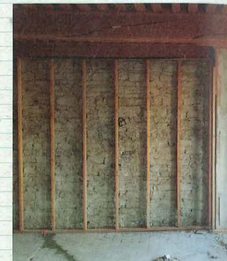
compenser les défauts de planéité du mur, une couche supplémentaire de panneaux en chanvre de 30 mm est interposée ponctuellement (découpée en bande et/ou au format approprié).
