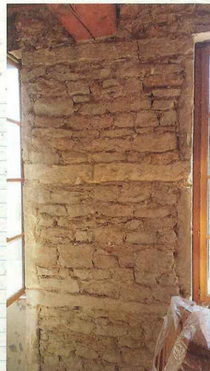
**1** Pour être sûr que l'enduit d'origine (incertain dans sa composition) ne vienne pas perturber les flux de vapeur, il faut décroûter le mur et le remettre à nu. Travail fastidieux, salissant, fatigant et non gratifiant, mais nécessaire ! Cette étape est réalisée au perforateur-burineur ou avec de l'huile de coude et un burin !
