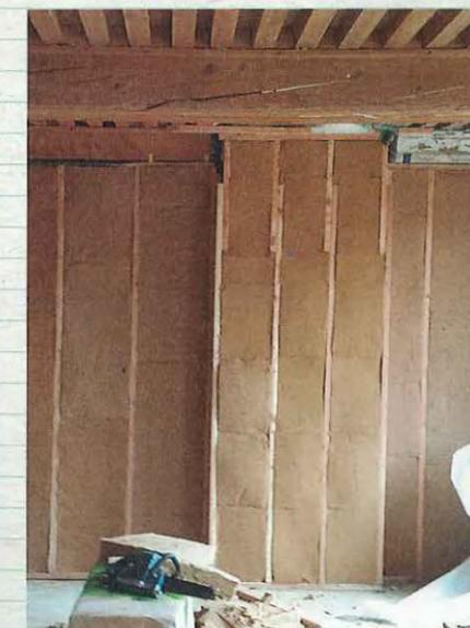
**4** L'isolant principal en laine de bois s'insère facilement entre les montants. Pour la découpe, préférez une scie alligator [article sur les outils de découpe dans le nouveau hors-série, voir p.78]. Avec 15 cm d'isolant au total, la résistance thermique (R = 3,9 m<sup>2</sup>.K/W) est supérieure aux critères actuels du crédit d'impôt.
